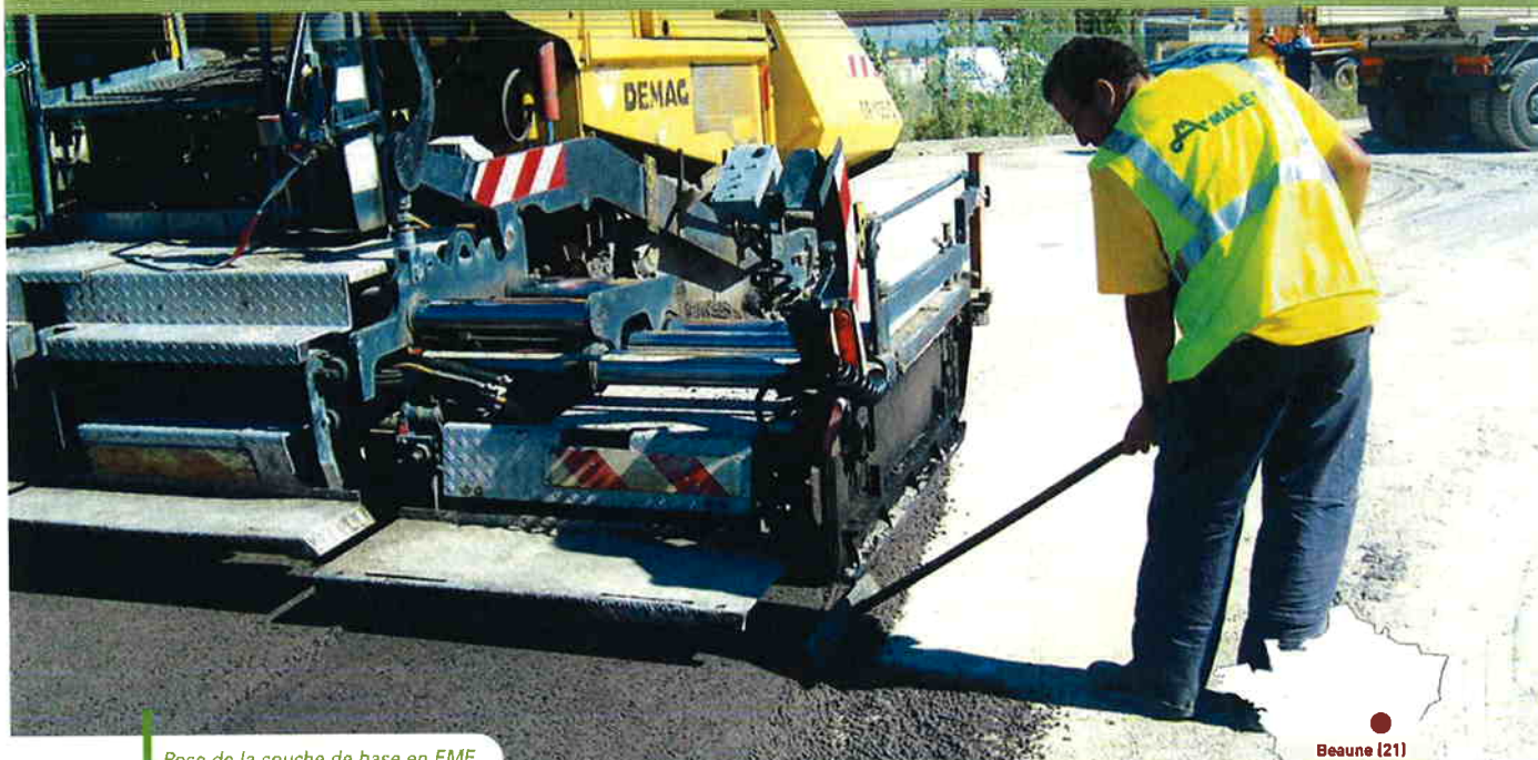
Pose de la couche de base en EME.
